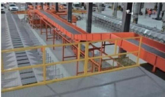
杭州圆通二级仓现场图
