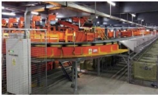
杭州圆通二级仓现场图1
